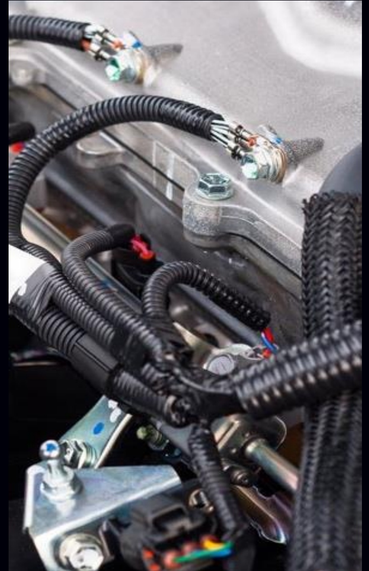
OEM: Kabelstecken in der Vormontage
